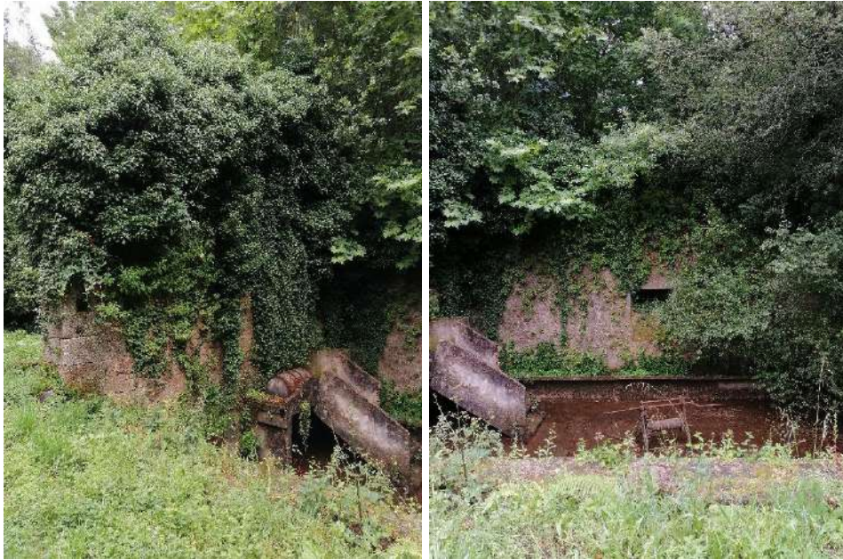
Imagen 14. Edificio de antiguo lavadero ideal para la instalación de cajas nido para murciélagos y rapaces nocturnas.
