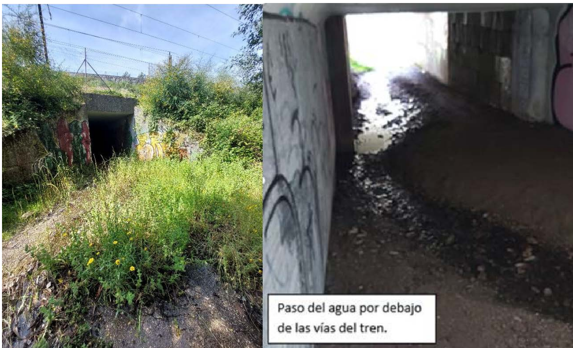
Imagen 12. Drenaje bajo vías de tren. Existe una acción para acondicionar el drenaje y se debe tener en cuenta incorporar un paso para fauna longitudinal en uno de los laterales.
